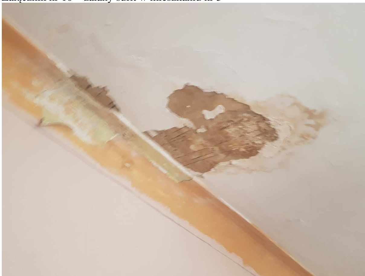
Załącznik nr 10 – zalany sufit w mieszkaniu nr 5
