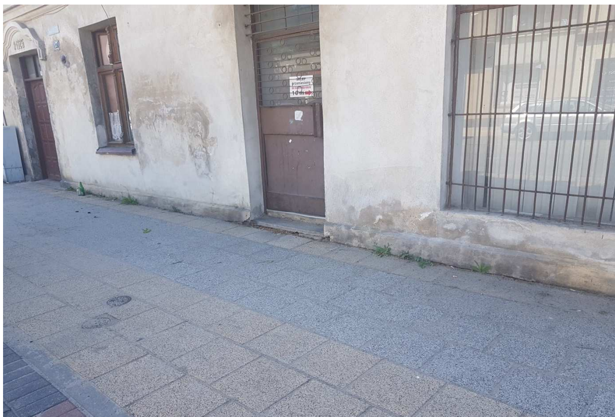
Załącznik nr 4 – zawilgocenie na elewacji frontowej
