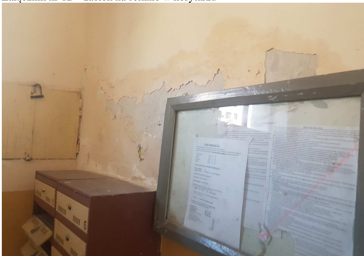
Załącznik nr 12 – zaciek na ścianie w korytarzu
