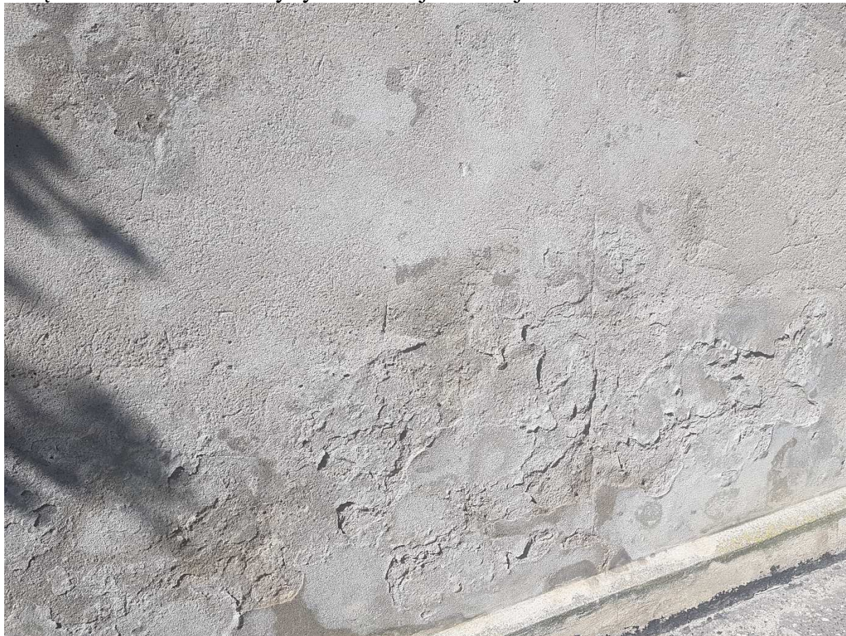
Załącznik nr 4 – zawilgocenie na elewacji frontowej
